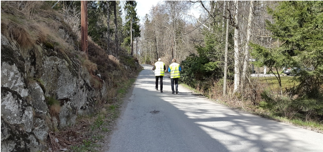
Figur 15. Boo strandväg norr om tunnelpassagen, platsbesök 160421
